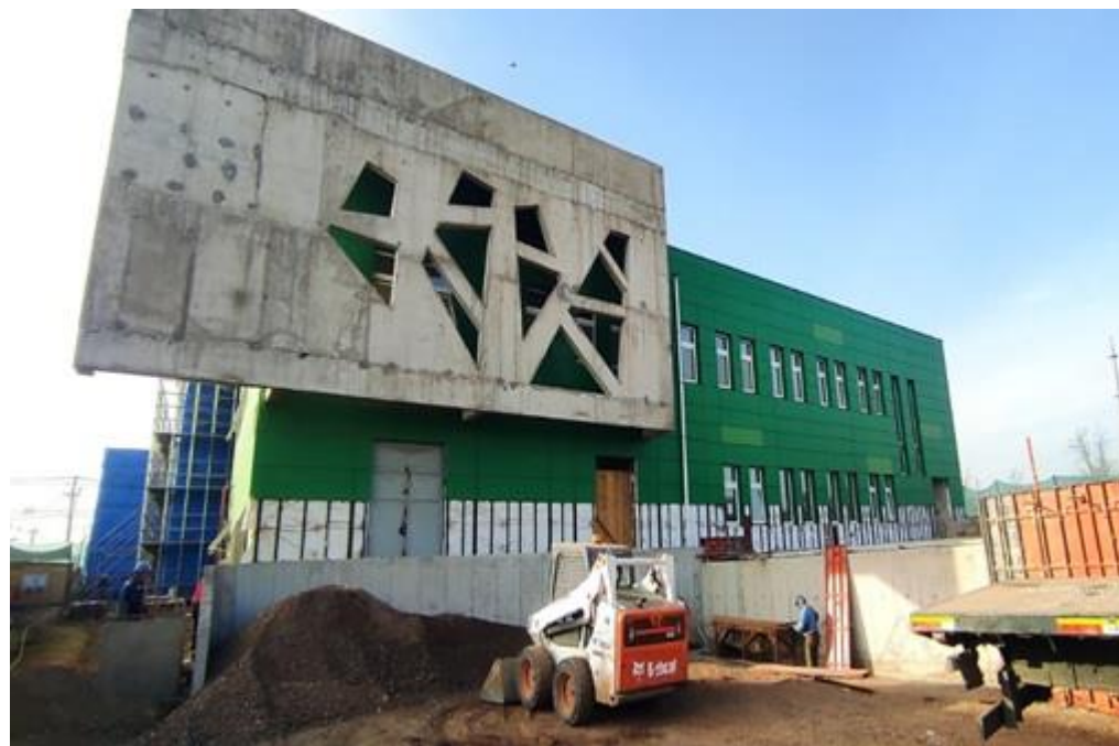
CESFAM "Dr. Salvador Allende", Maipú 71% de avance en la obra
