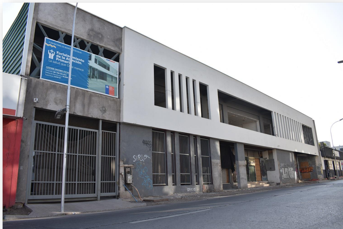
CESFAM "Erasmus Escala", Santiago 89% de avance en la obra
