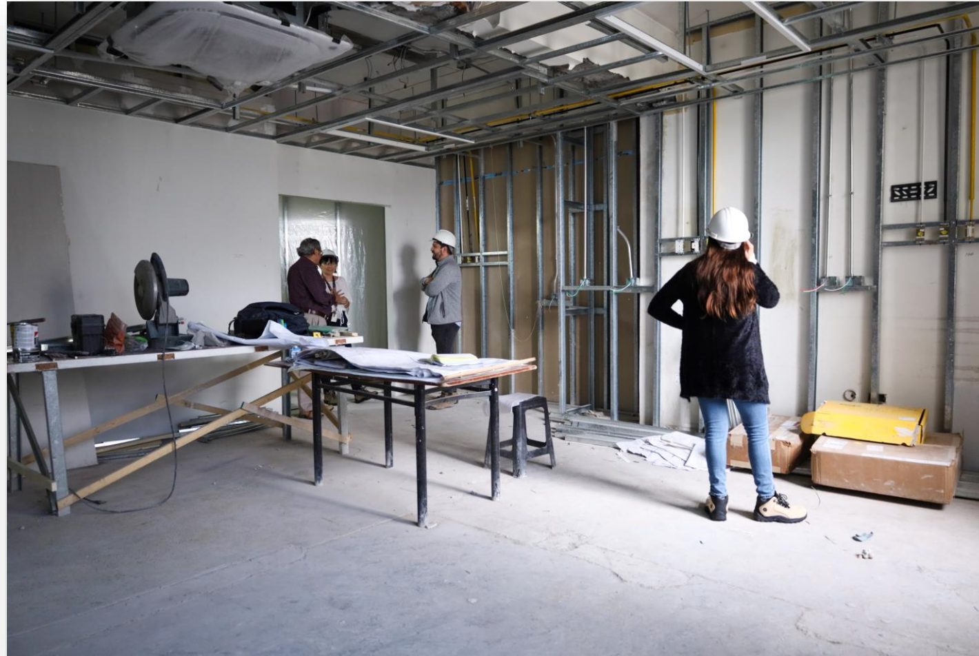
Recuperación Pabellones Torre Antigua
