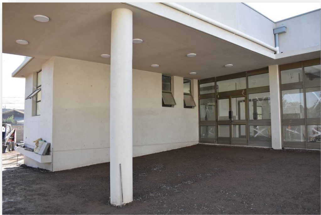
SAR "Pdta. Michelle Bachelet", Maipú 80% de avance en la obra
