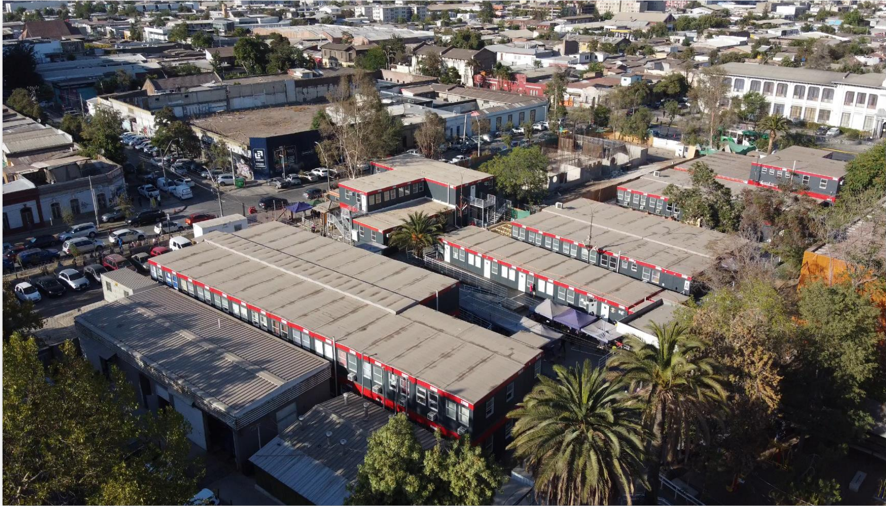
Reconstrucción Centro de Diagnóstico y Tratamiento, Hospital Clínico San Borja Arriarán 8% de avance en la obra
