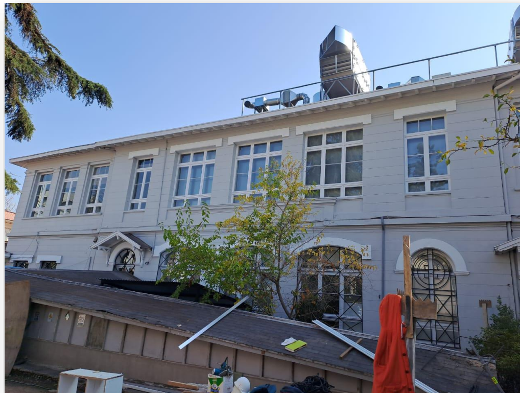
Reposición Laboratorio de Tuberculosis, Hospital Clínico San Borja Arriarán 70% de avance en la obra
